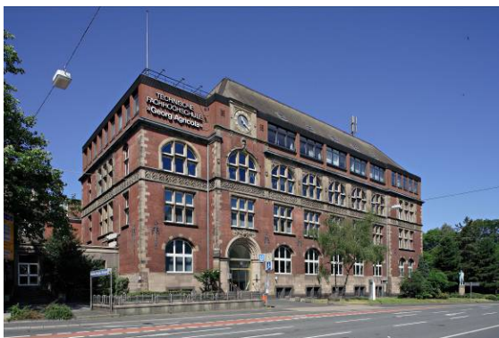
Abb. 81/82: Das Gebäude der ehemaligen WBK, um 1900, und heutigen TFH Georg Agricola zu Bochum ( montan.dok )
