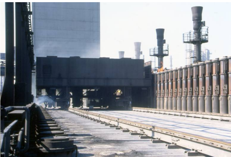
Abb. 84: Ofendecke und Füllwagen der Kokerei Kaiserstuhl III, Dortmund, 1990er-Jahre (Archiv Koßke)
