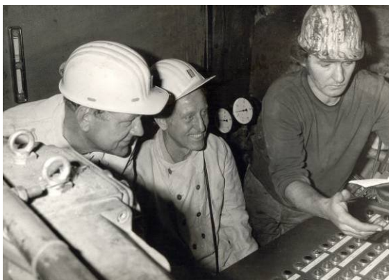
Abb. 19: Inbetriebnahme der Vollschnittvortriebsmaschine auf dem Verbundbergwerk Rheinland, 12. Oktober 1973 ( montan.dok/BBA 306/11 )
