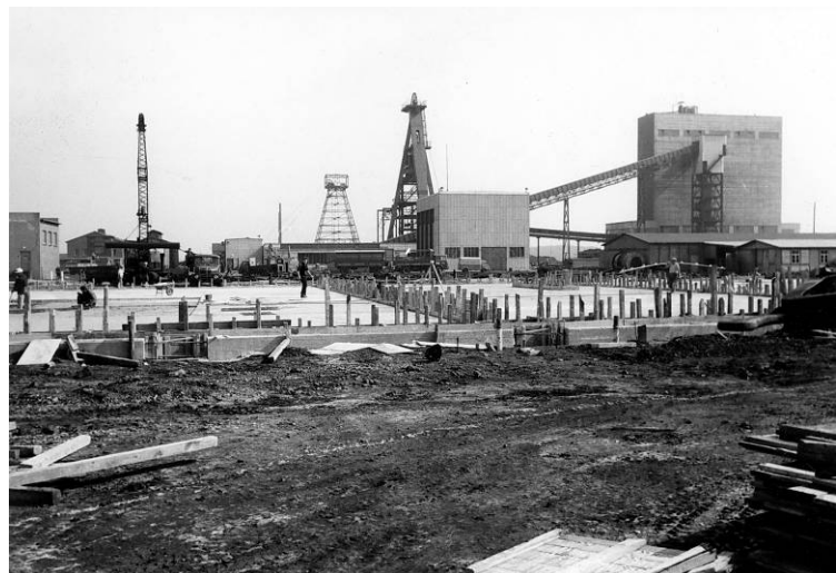
Abb. 79: Bau der Tagesanlagen Rossenray, 1964 ( montan.dok/BBA )
