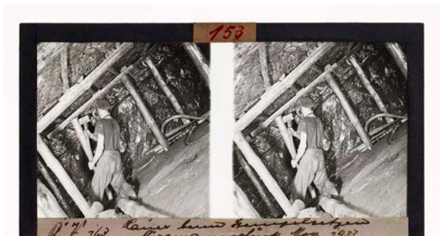
Hauer beim Setzen von Holzstempeln in halbsteiler Lagerung, 1933 (montan.dok 120160015301)
