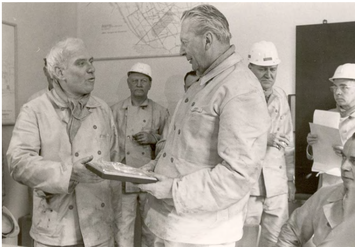
Walter Arendt und Bundeskanzler Kurt Georg Kiesinger anlässlich eines Besuches der Schachtanlage Rossenray, vermutlich 1967 (BBA 247/14)
