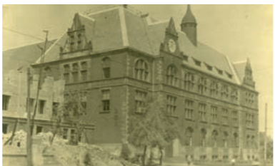
Dienstgebäude der Westfälischen Berggewerkschaftskasse seit 1899 Reproduktion einer Fotografie, undatiert Fotograf unbekannt montan.dok/Bergbau-Archiv 120/12137
