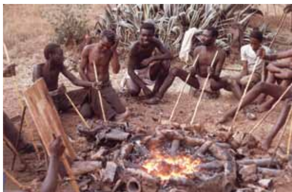
Abb. 91: Eisenverhüttung in einem offenen Herdfeuer mit Einsatz von Blasebälgen (Celis 1991, Abb. 60).
