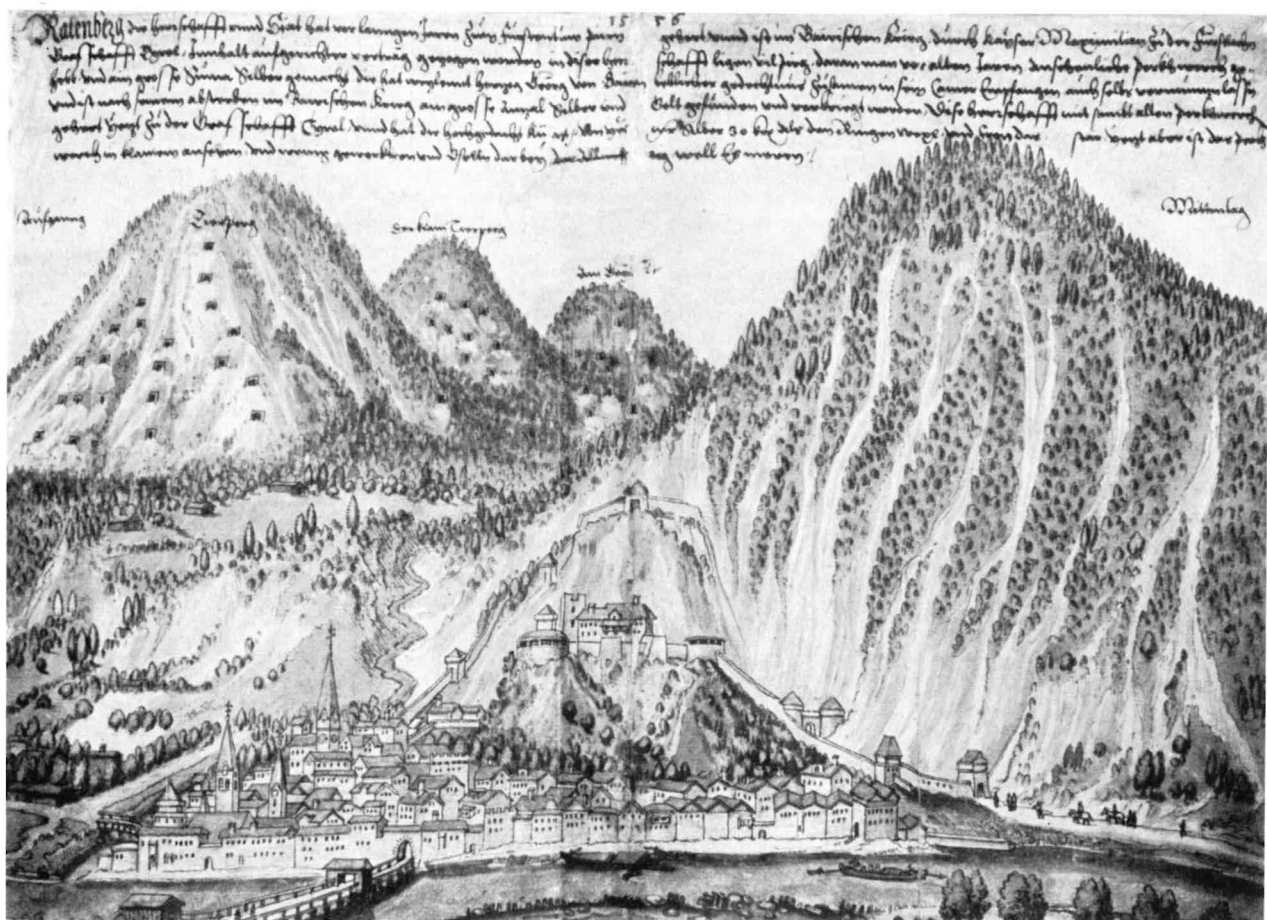
„Rattenberg“. Reihenartig liegen die Stollen untereinander und zeigen deutlich den fast senkrechten Verlauf der abgebauten Gänge. (Innsbruck Dip. 856)
