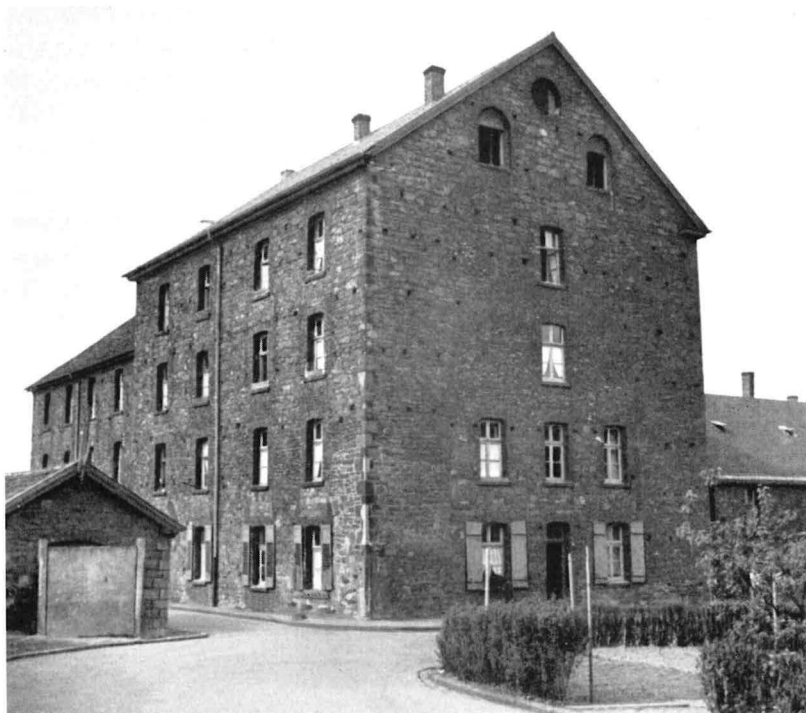
Schachthaus der Spateisenzeche Müsen III in Welper-Hüttenau. Unter dem hohen Gebäudeteil befand sich der Schacht. In dem um ein Stockwerk niedrigeren Anbau im Hintergrund stand die Maschine für die Gestänge-Wasserhaltung. An der vorderen Giebelwand befand sich früher vermutlich ein zweiter Anbau, in dem die Fördermaschine untergebracht war.
