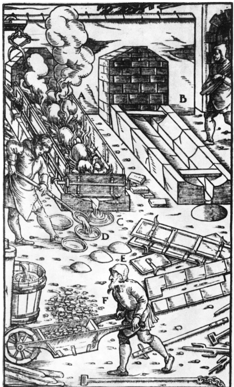
Der Saigerherd in Betrieb A. Derselbe außer Betrieb B. Der Sumpf C. Kleine runde Formen D. Kuchen von Saigerblei E. Saigerdörner F.
