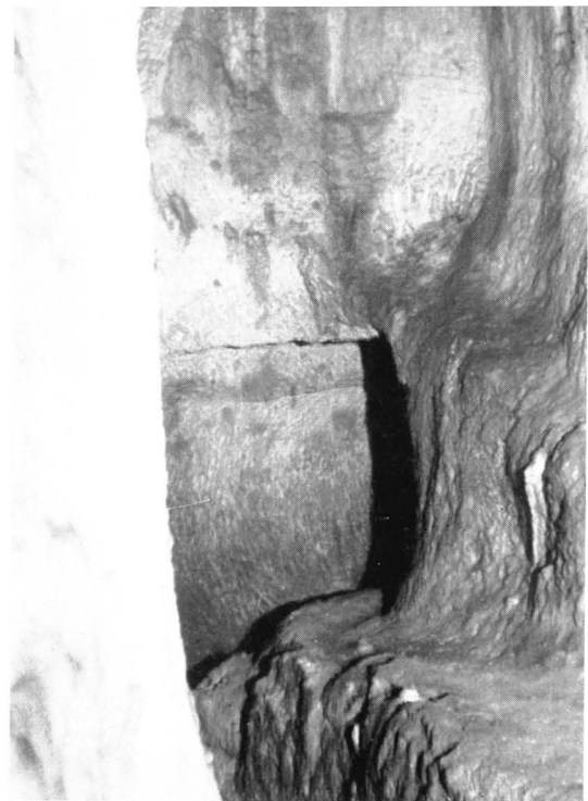
Abb. 8: Durchschlagspunkt zwischen dem nördlichen und südlichen Stollen, die hier annähernd rechtwinklig aufeinanderstoßen.
