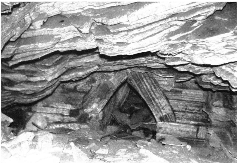
Abb. 13: Bruchzone. Im Hintergrund dachförmiger Firstenausbau.
