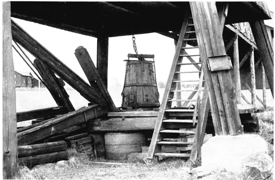
Abb. 4, rechts: Schachtbühne mit Förderkübel. Links die Kunstkreuze für das Pumpengestänge. Darunter das hölzerne Rohr für das Grubenwasser.
