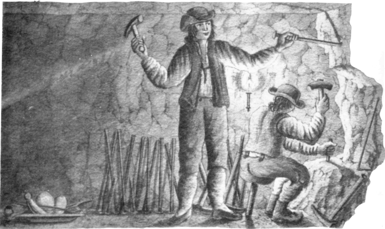
Abb. 3: „Stellt vor, wie bey dem Betrieb der in Kalkstein befindlichen Hauptschachtrichten von zwei Häuern, nämlich von dem einen stehend und von dem anderen sitzend, die Bohrlöcher gemacht werden.“ (Tabelle XIII/D der Manipulationsbeschreib. von 1837.)
