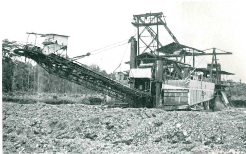
Einer der altertümlichen Schwimmbagger.
