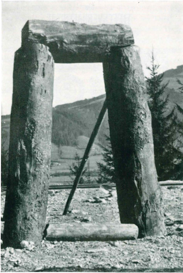
Oben: Türstock aus alter, 1953 angefahrener Strecke im Horizont der dritten Sohle des Geisterschachtes. Der Türstock hat eine lichte Höhe von 160 cm und eine lichte Breite von 60—70 cm. Die Stempel und die Kappe aus Lärchenholz sind 41—45 cm stark. — Unten: Der Röhrenbühel im November 1954.
