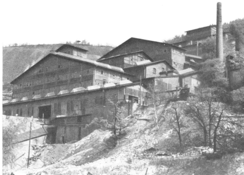
Abb. 8: Die Aufbereitung der Grube Ver. Bastenberg und Dörnberg in Ramsbeck, 1966. Das Erz wird in einem Blindschacht bis zur Stollenssole und von dort in einem ansteigenden Bandberg in die Aufbereitung gefördert.
