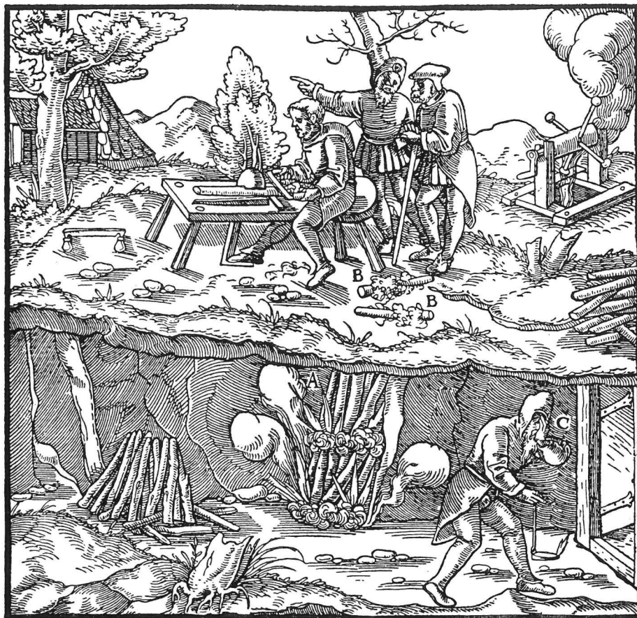
Die zeitgenössische Darstellung des Feuersetzens zeigt die aus dem Schacht ausziehenden Rauchswhaden. Die Vorstellung vom brennenden Berg und von der Hölle mag zu entsprechenden Flurnamen geführt haben (2.10 u. 2.20). — Holzschnitt aus Georgius Agricola „De re metallica“, Basel 1556.
