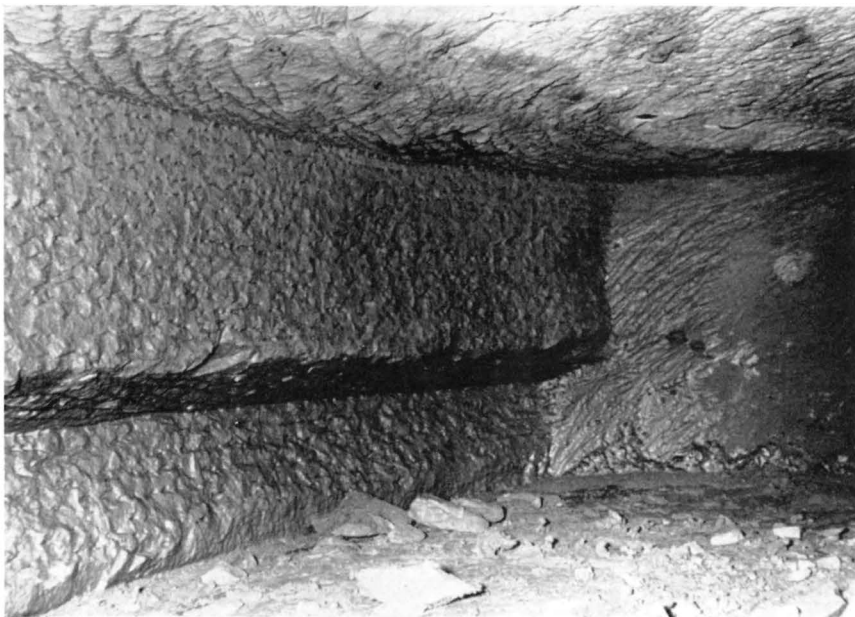
◄ Relativ grobe Spuren auf der nachgearbeiteten Stoßfläche eines mittelalterlichen Keilreihenabbaus. Der Grundschräm für die obere Hälfte ist hier selbst in Form eines Keilreihenabbaus ausgeführt; die Spuren in der oberen und unteren Hälfte sind daher analog. Zu beachten ist weiter, daß der optische Eindruck sehr stark durch die Verlehmung verändert wird. Auf der Fläche des rechten Seitenschrams hat der Verfasser die Lehmhaut teilweise entfernt. Die Fläche erscheint dort viel glatter. Stollen im Blauwald, Pkt. 271.
