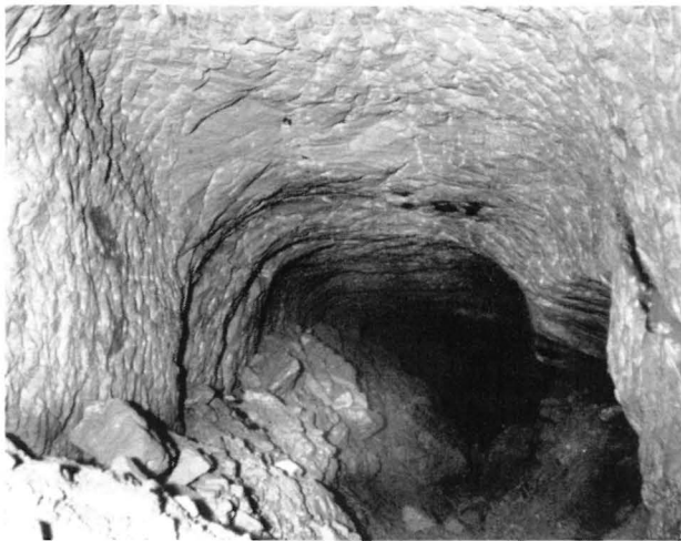
▲ Starker rechteckiger, aber merklich gerundeter römischer Stollenquerschnitt zwischen Pkt. 8—9 im Stollen Bruss.
