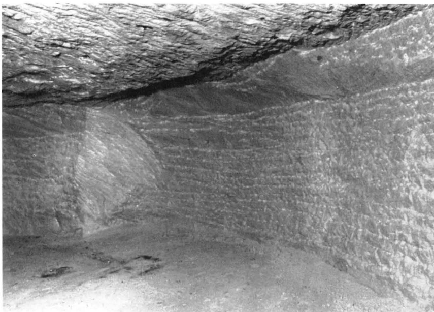
◄ Mittelalterlicher Ortsstoß, der nach dem Abkeilen in der häufigeren Weise bei flach angesetzten Bergeisen nachgearbeitet wurde. Stollen im Blauwald, Pkt. 235.
