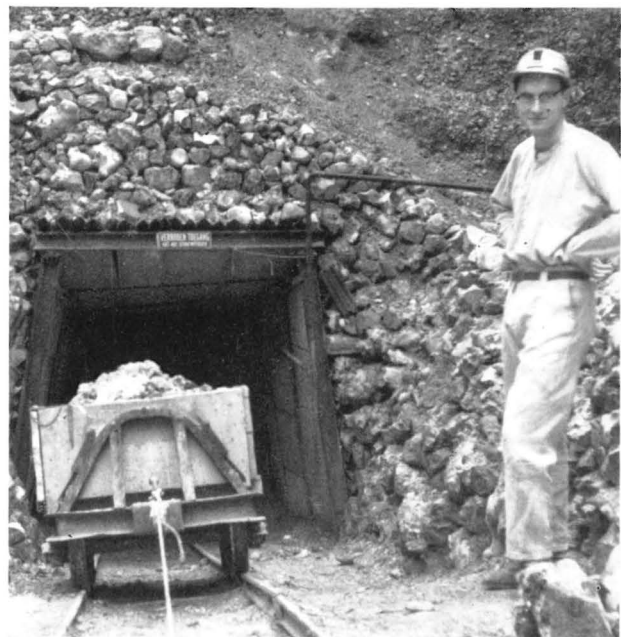
▲ Stollenmundloch des 1964 begonnenen vom Hang aus vorgetriebenen Stollens, der prähistorische Grubenbaue aufschließt
