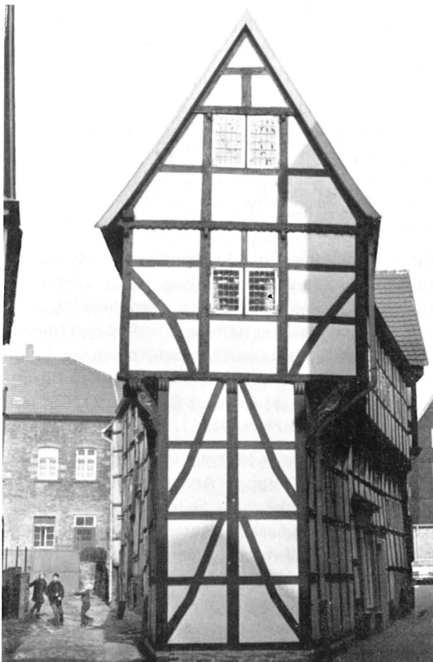
▼ Hattingen, das alte Fachwerkhäus, der Alterssitz von Otto Wohlgemuth, wurde von der Stadt als Museum eingerichtet
