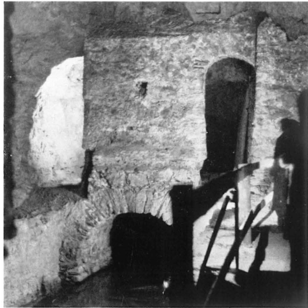
▲ Stříbro (Mies), Radstube und Zuleitungsgraben der Wasserkunst am Procopi-Gangzug aus dem 18. Jahrhundert
