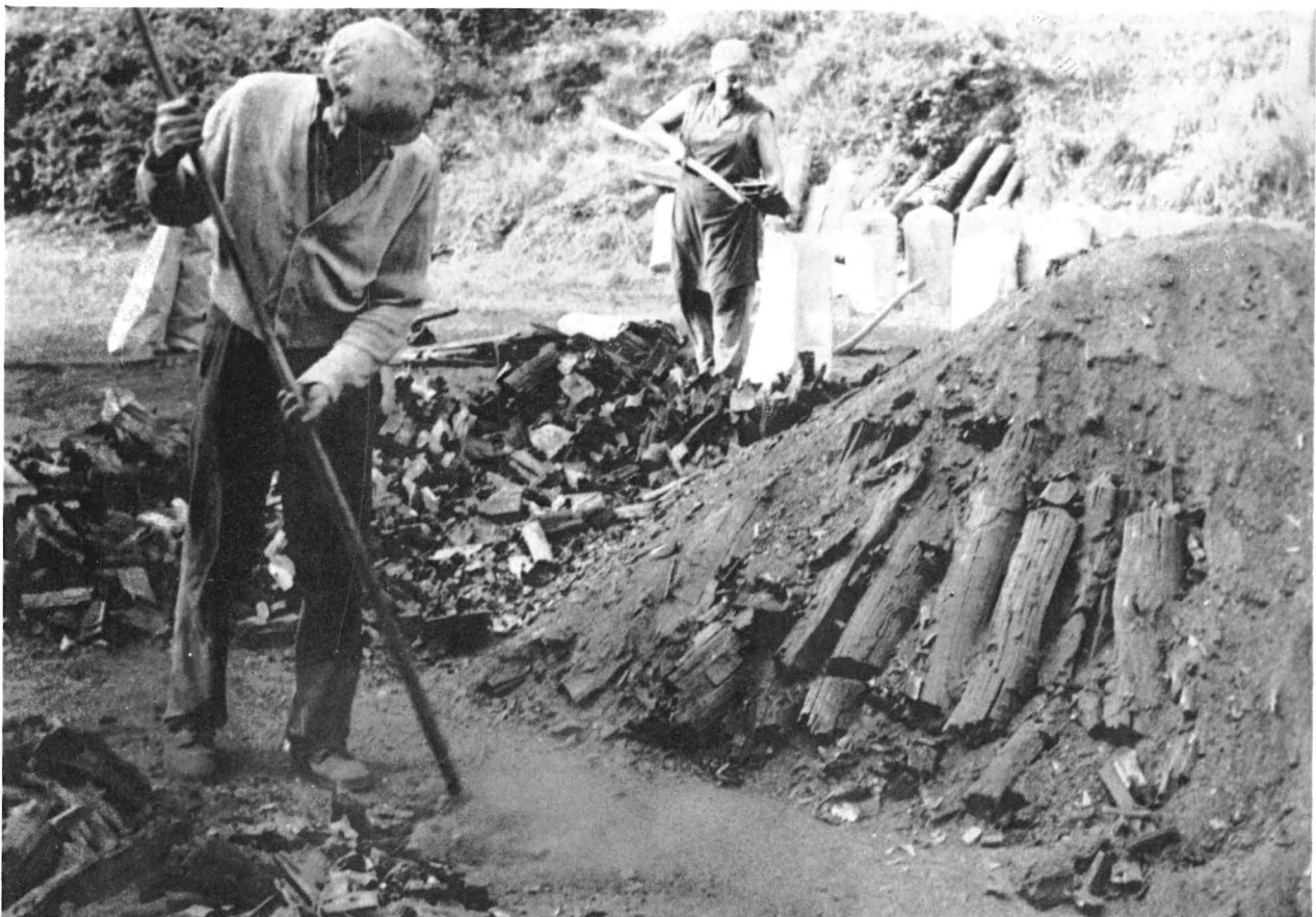
Abb. 6: Der Köhler hat die Holzkohle entblößt und zieht sie aus dem Meiler. Nach dem Abkühlen wird sie in Papiersäcke gefüllt
