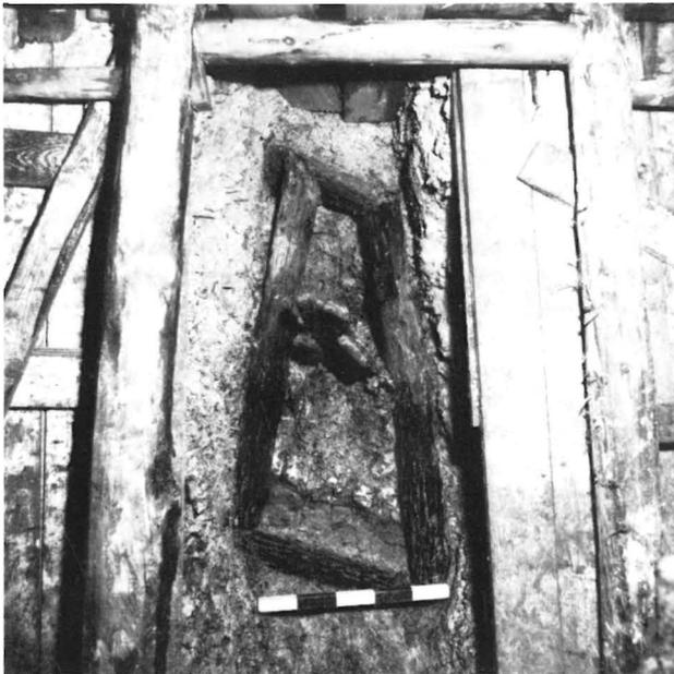
Vierter Ausbaurahmen der 1. Sohle in Schacht 2 mit hochgedrückten Sohlenbrettern
