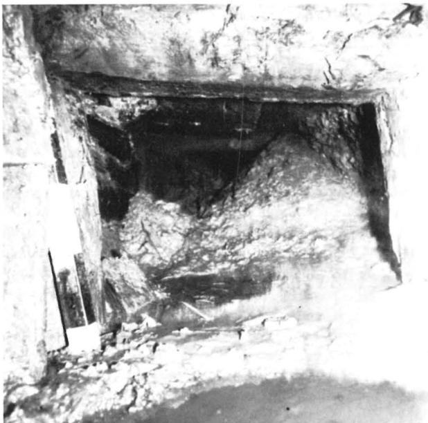
seite rd. 20 cm abgesackt war, schwankte die aufgefundene Form des Querschnittes zwischen Parallelogramm und Trapez. Erst die Vermessung der Hölzer ergab den rechteckigen Querschnitt. Drei der übrigens dicht aneinander stehenden Ausbaurahmen konnten geborgen werden. Jedes weitere Vordringen in der alten Strecke wurde vermieden, um umfangreiche Ausbaumaßnahmen zu umgehen, die kaum im Verhältnis zum weiteren Erkenntnisgewinn gestanden hätten.
