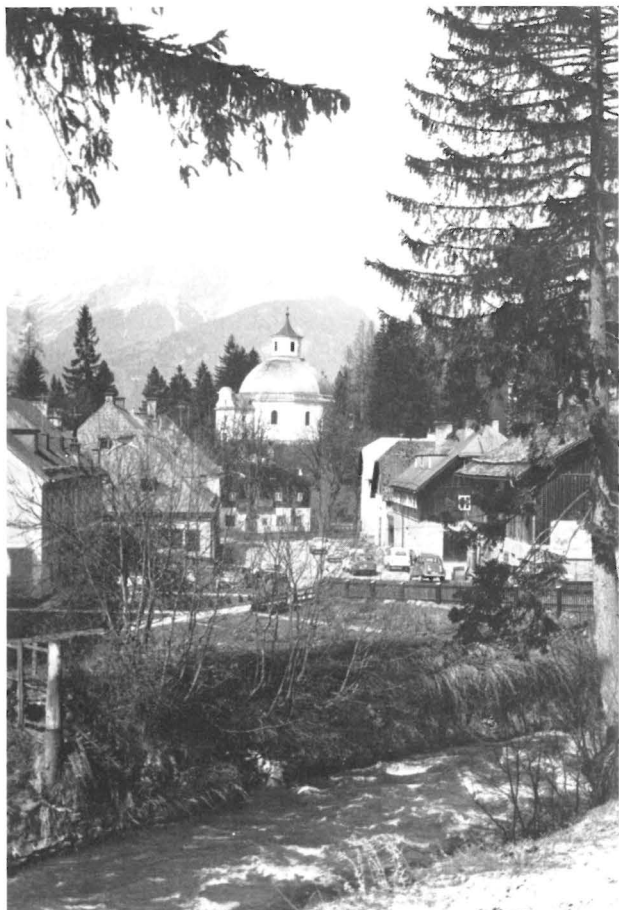
Abb. 5: Blick auf die Kernzone von Altböckstein (Aufnahme 1977)
