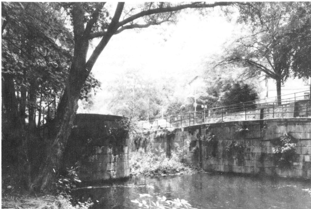
Abb. 3: Ruhrschleuse Neukirchen bei Essen-Werden, erbaut 1776/78
