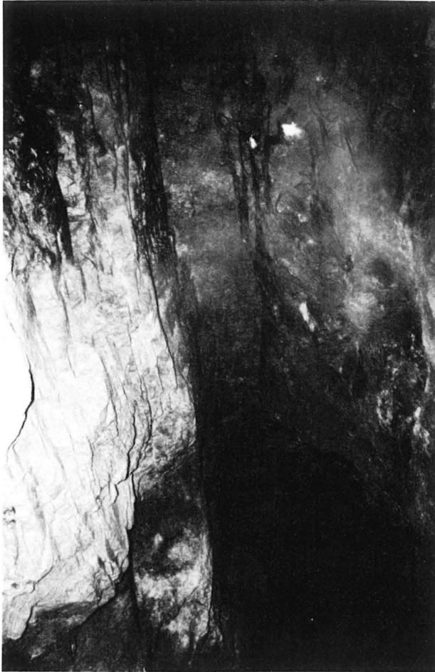
Abb. 14: Lemberg. Schmittenzug, an der Firste des in den 30er Jahren erweiterten und nachgerissenen Stollens die Firste des Stollens aus dem 18. Jh.
