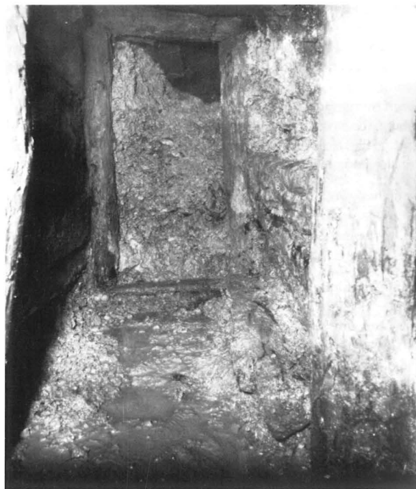
Altenberg. Schacht 2. Blick in Strecke 18/19 mit Stempel, Kappe und Sohlbrett des Streckenausbaus
