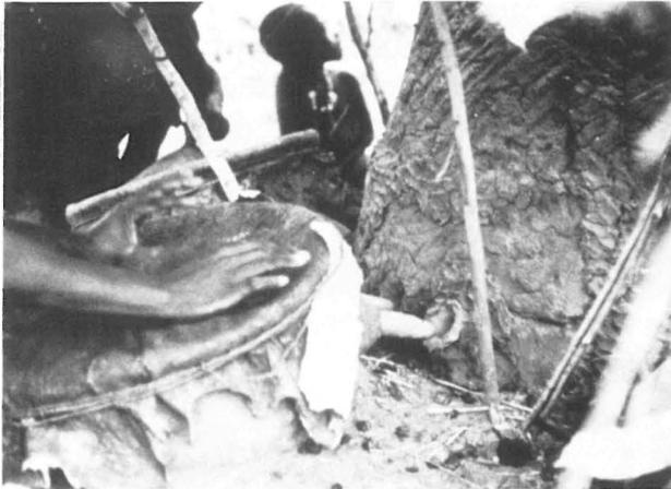
Abb. 10: Anordnung der Windformen und Betrieb des Schalen-gebläses
