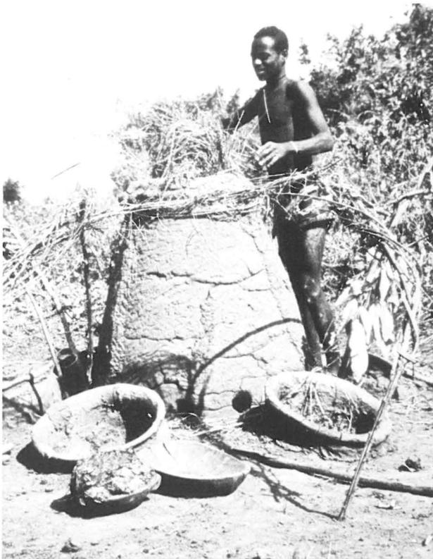
Abb. 13: Renneisenstücke werden aus dem Ofen gereicht
