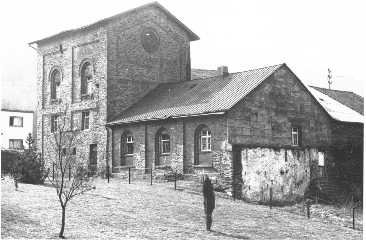
Abb. 24: Grube Apfelbaumer Zug: links das Schachtgebäude, in der Mitte das Fördermaschinenhaus, rechts der Platz des abgebrochenen Kesselhauses (um 1975)
