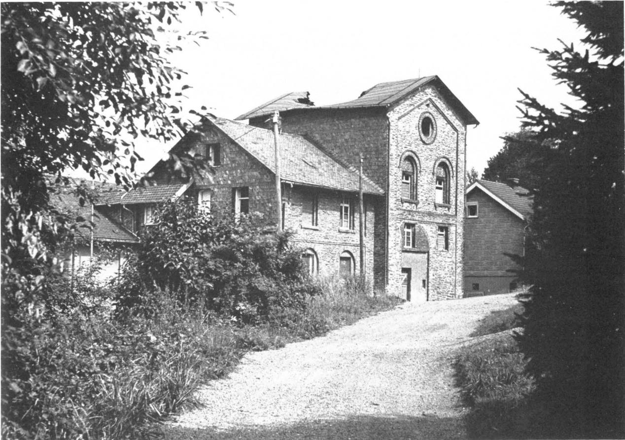
Abb. 26: Grube Apfelbaumer Zug: links die jüngeren Anbauten, in der Mitte der Wasserhaltungsraum, rechts die Schachthalle (um 1975)
