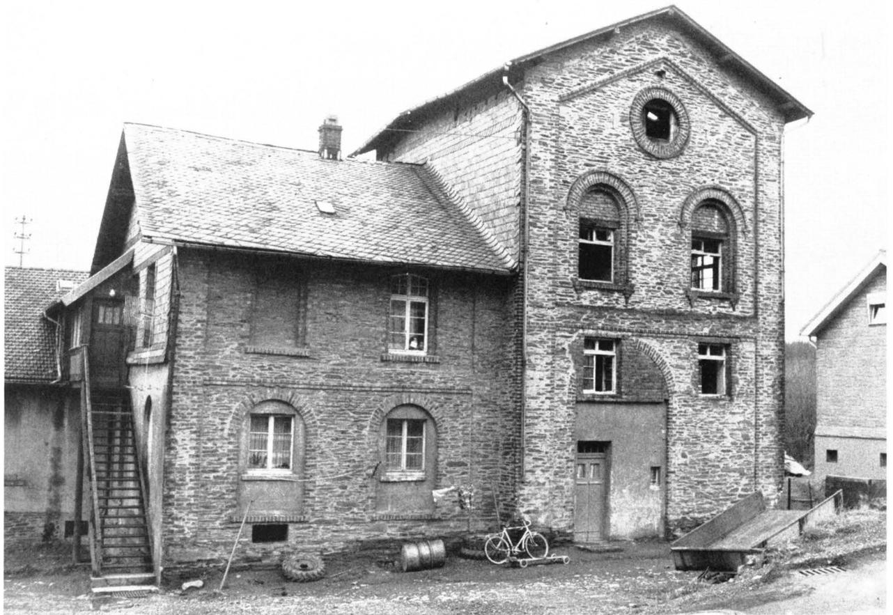
Abb. 27: Grube Apfelbaumer Zug: Südfront mit der Schachthalle (rechts), dem Raum für die Wasserhaltung (Mitte) und den jüngeren Anbauten (links)
