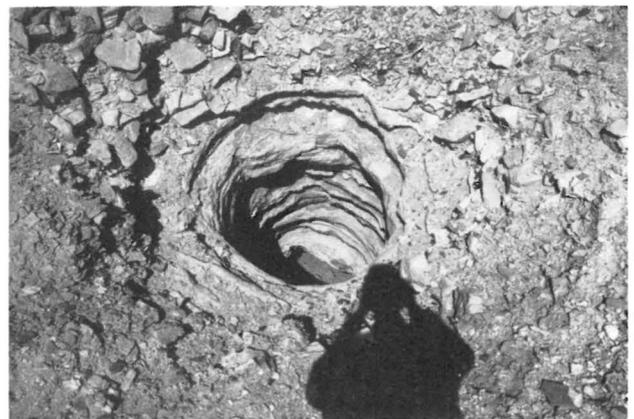
Abb. 19: Wadi el-Sheikh. Mundloch von Schacht 1 inmitten einer Ringhalde. Der Schacht ist über die Unebenheiten am Stoß gut befahrbar
