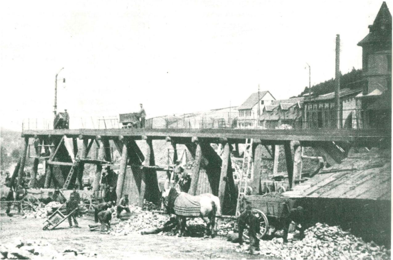
Abb. 5: Erzbergwerk Rammelsberg. Erzsturzbrücke mit den drei Rostsystemen, Sortieren und Abfuhr der Erze um 1910
