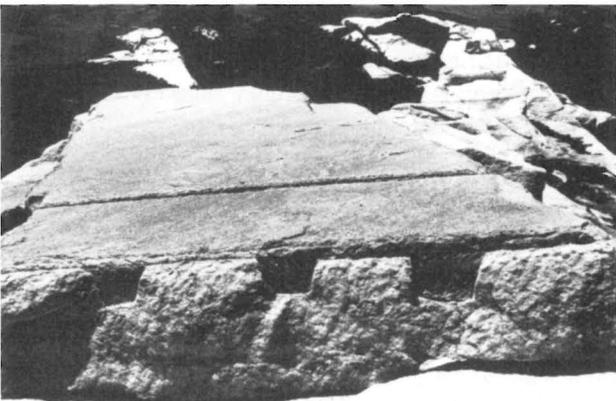
Abb. 13: Aiki. Auf dem Block ist die nächste Keilnut angebracht
