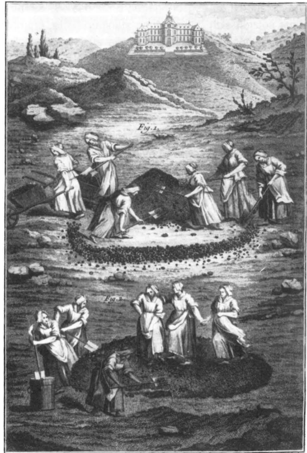
Abb. 5: Trennung der Kohlestücke vom Kohlenstaub, der zu Briketts verarbeitet wird
