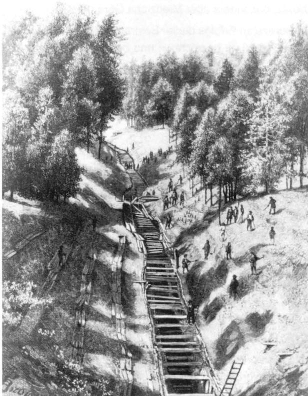
Mit Ausnahme des Tatra-Gebirges und der niederschlesischen Reviere wandte man nicht das Wasser als Triebkraft im Erzbergbau an. Es ist nur ein Beispiel bekannt, wo eine durch Wasserkraft getriebene Stangenkunst zur Grubenentwässerung arbeitete, dies geschah in der Nähe von Tarnowskie Góry, und dort auch nur für kurze Zeit. Die Hauptantriebskraft blieben die Pferde.
