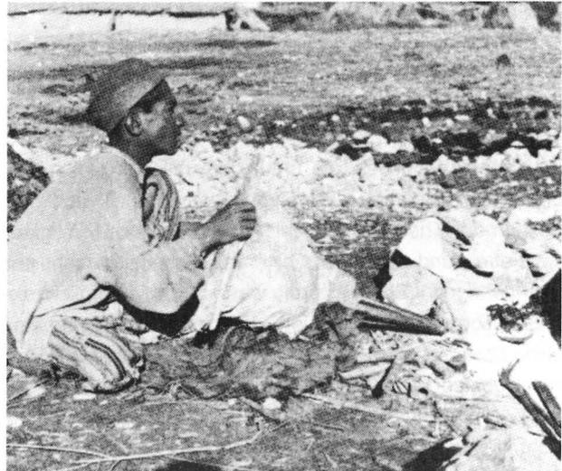
Abb. 3: Helfer eines Schmiedes in Iran bei der Betätigung eines doppelten Schlauchgebläses
