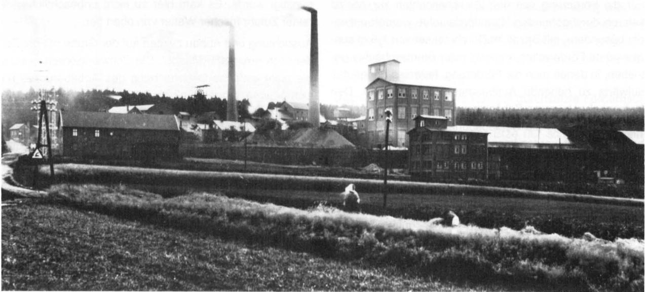
Abb. 3: Grube Bindweide. Gesamtansicht der Tagesanlagen im letzten Ausbauzustand. Rechts neben den Gebäuden für die Rohspat- und Rostaufbereitung die Röstanlage
