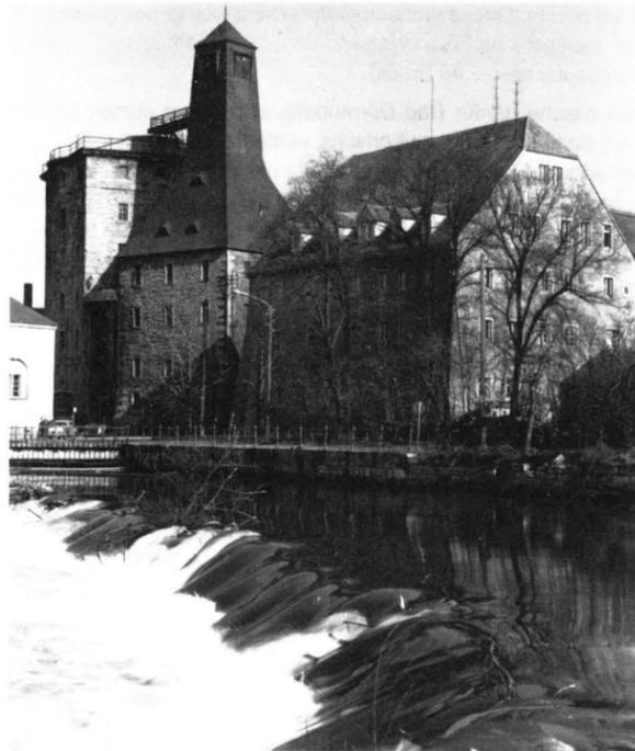
Bad Dürrenberg. Witzlebenschacht, Borlachschant und ehemalige Salinendirektion (von links). Vorn das von Borlach für den Antrieb der unterschlächtigen Wasserräder angelegte Wehr
