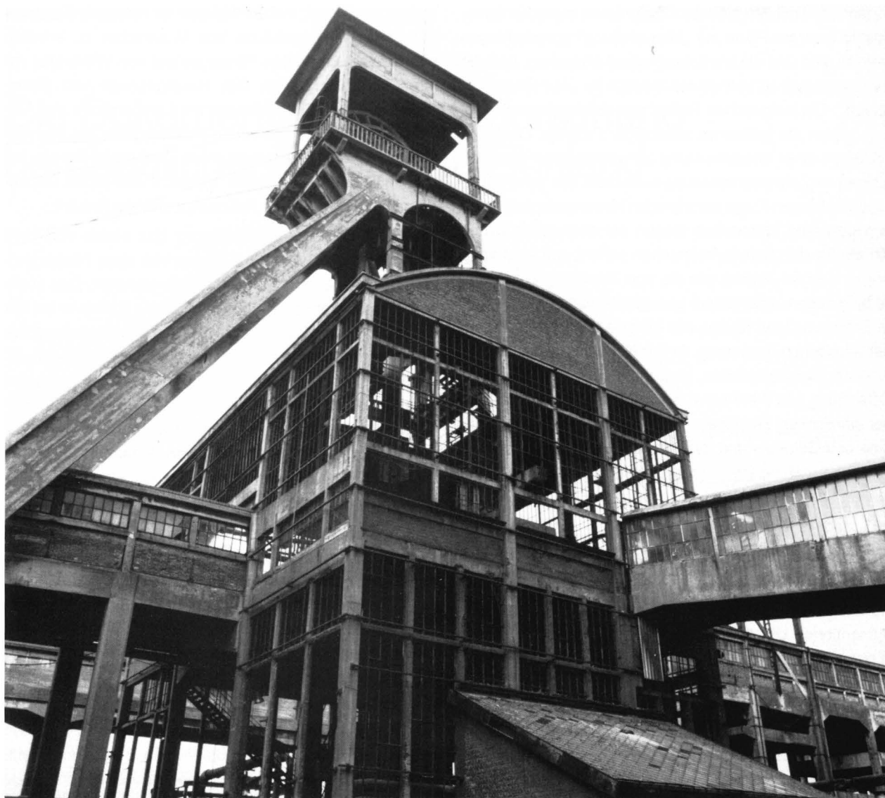
Abb. 7: Eisdien. Fördergerüst Schacht 1 von 1920/21
