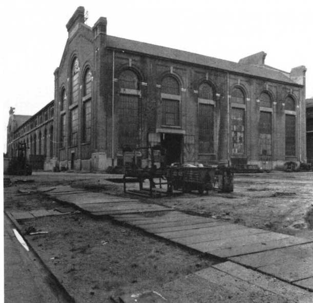
Abb. 8: Eisdien. Maschinenhaus mit den vier erhaltenen Fördermaschinen an den Stirnseiten
