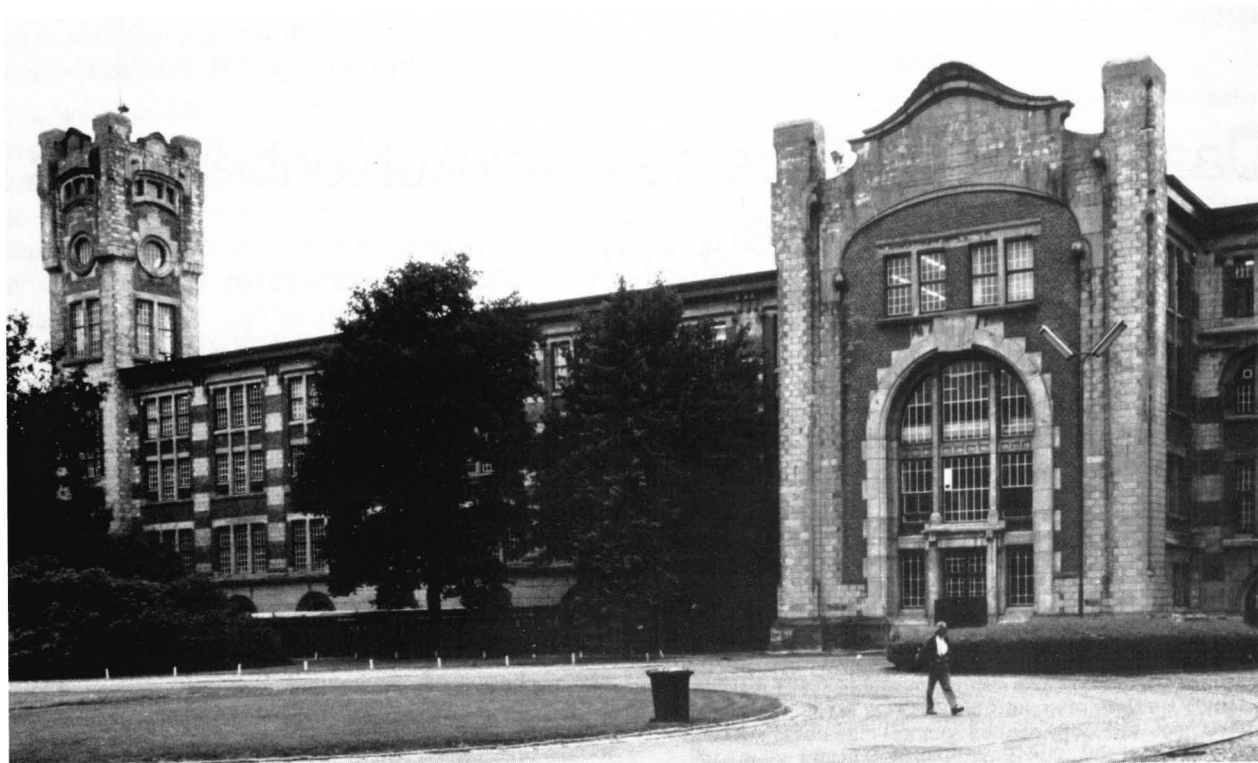
Abb. 1: Waterschei. Hauptgebäude der Schachtanlage
