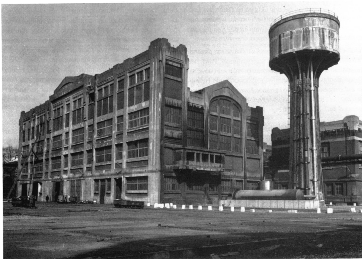
Abb. 2: Waterschei. Elektrizitätswerk mit Wasserturm
