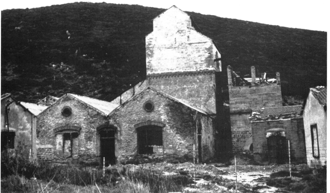
Abb. 5: Argentera. Stillgelegtes Blei-Silber-Bergwerk (Aufnahme 1985)
