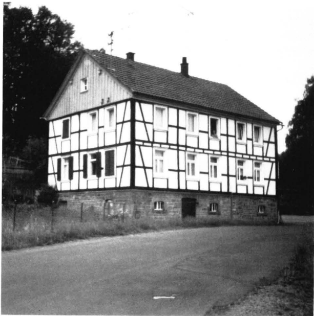
Much-Wellerscheid, Grube Aurora. Ehemaliges Wohnhaus des Betriebsführers (Aufnahme 1989)
