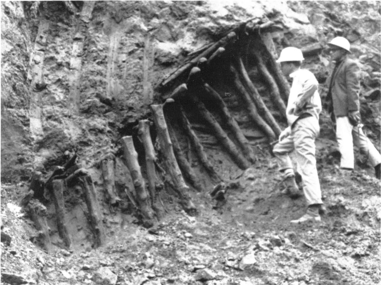
Abb. 17: Apliki. Im modernen Tagebau angeschnittener tonnlägiger Schacht mit noch 129 Stempelreihen, ca. 5. Jh. v. Chr. (Aufnahme vor 1969)
