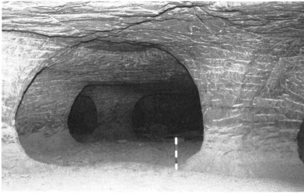
Abb. 18: Umm el-Amad bei Fenan, römischer Kammer-Pfeiler-Bau. Feine Schlägel- und Eisenspuren an den Bergfesten
