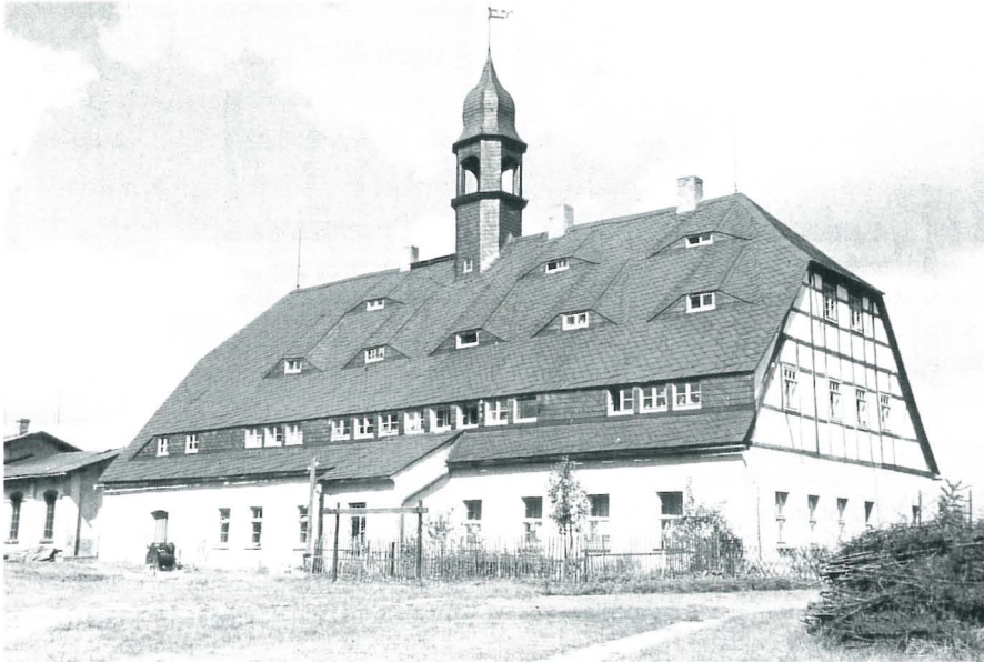
Brand-Erbisdorf. Huthaus der Beschert Glück Fundgrube von 1786, Dachreiter von 1815; am linken Bildrand das Maschinenhaus und (etwas höher) das Kesselhaus für die 1898, ein Jahr vor Stilllegung der Grube aufgestellte Fördermaschine
