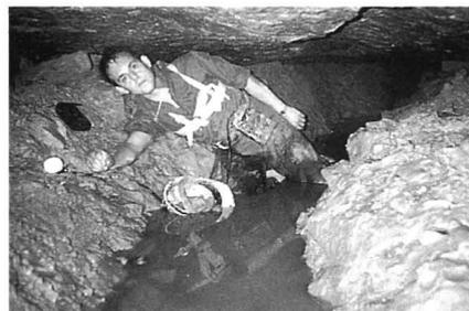
Abb. 6: Wallerfangen/St. Barbara, Blaufels-Schacht. Die Abbaue sind fast bis zur Firste verschlamm
