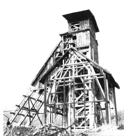
Abb. 12: Hölzerner Förderturm mit Seilscheiben-Gerüst der Dosza-Grube in Praid
