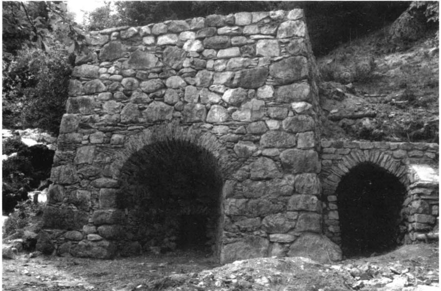
Abb.10: Ofenstock des Floßofens nach dessen Sanierung und Sicherung
