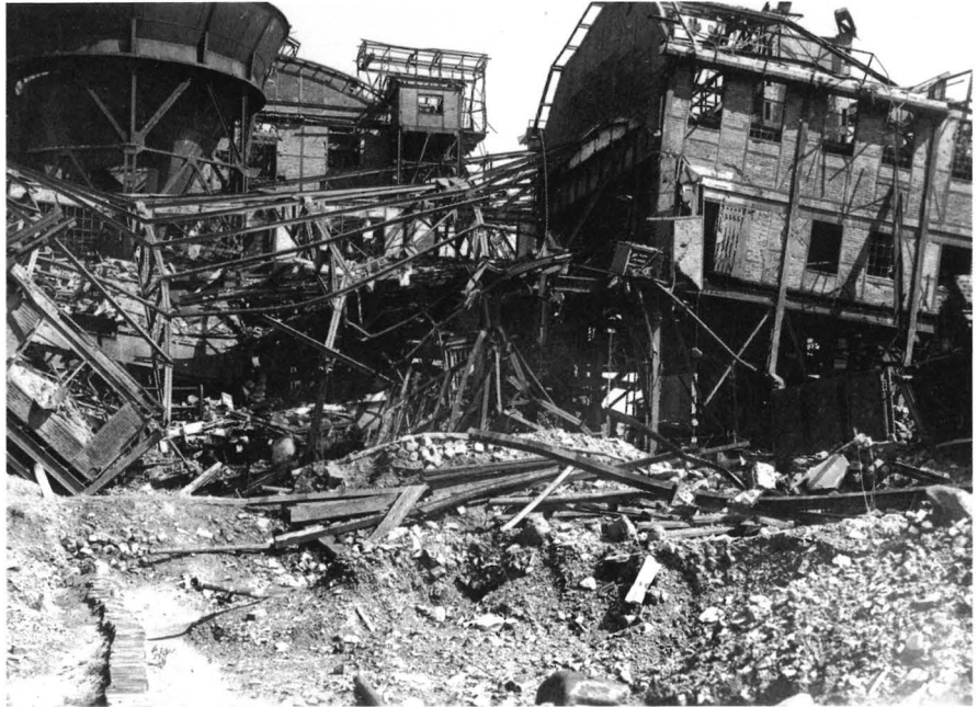
Schacht I der Zeche Grimberg I/II
