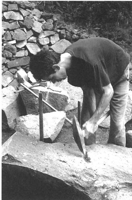
Abb. 7: Ausschlagen einer Keilrille an einem Basaltlava-Rohblock mit der Zweispitz
