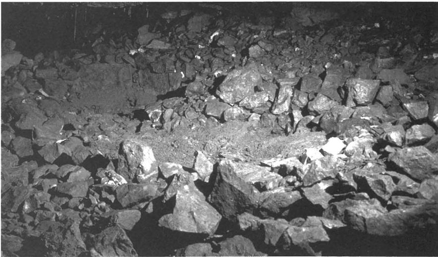
ringere Größe von Blöcken aus Verbrüchen oder von Material, das nach dem Ende des Bergbaus anfiel. Sie haben in der Firste Ausbrüche hinterlassen und liegen stratigrafisch auf dem Versatz (Abb. 9).
