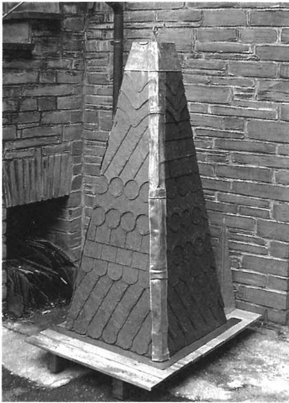
Die Rekonstruktion einer Eckpyramide nach Originalbefunden
