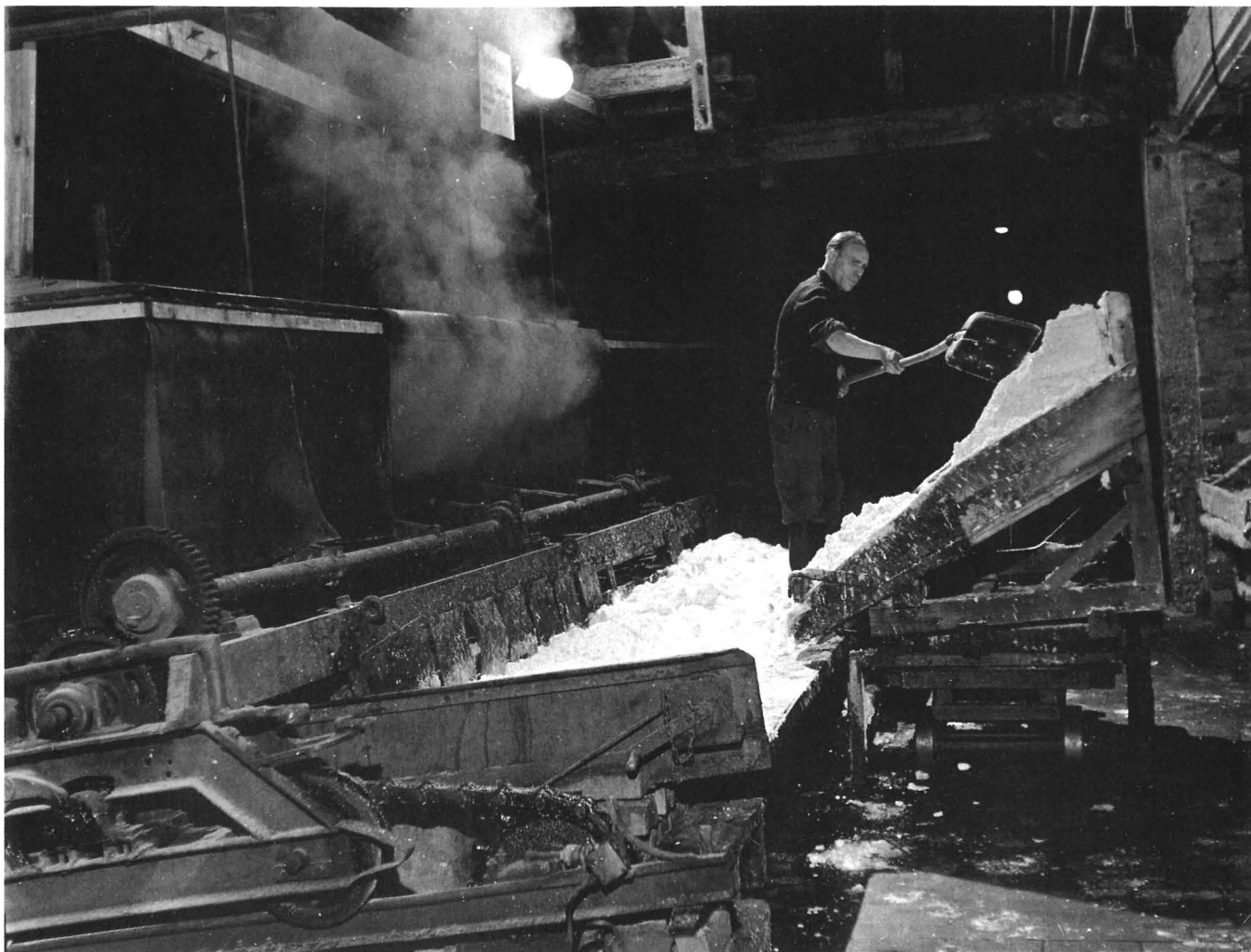
Abb. 13: Großsiedehaus der Saline Hallesche Pfännerschaft, Siedepfanne mit mechanischer Austragvorrichtung, ca. 1959
