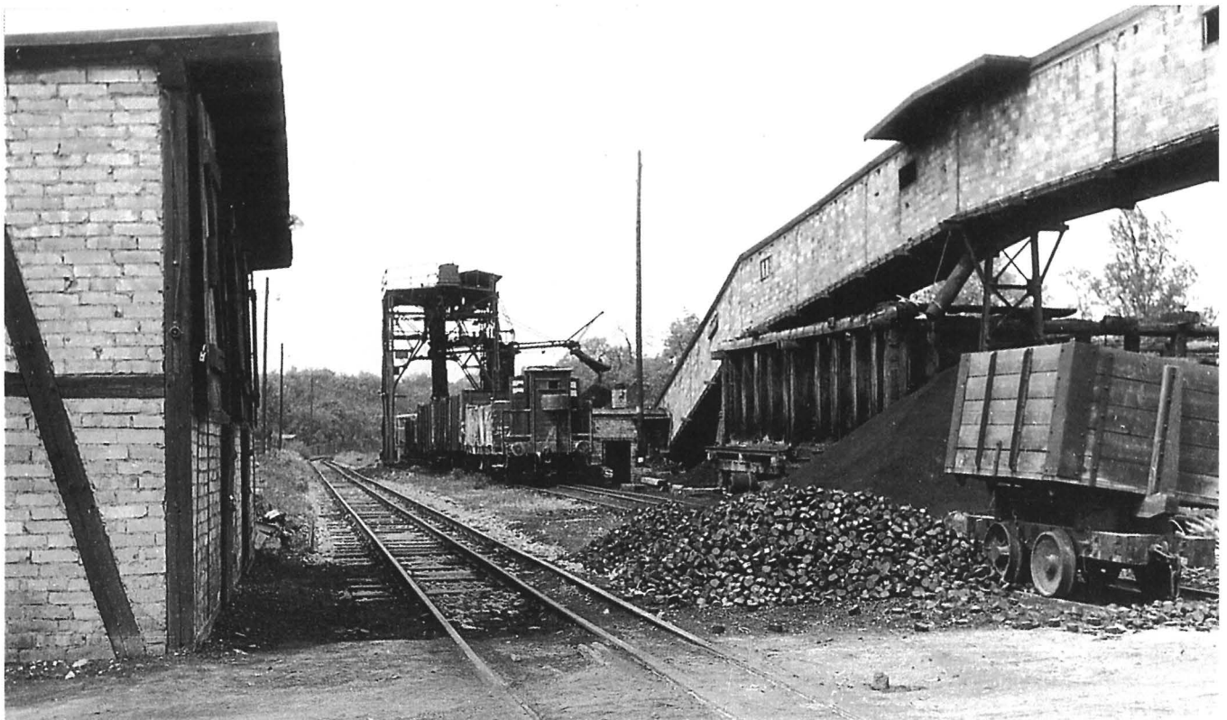
Abb. 7: Kohleentladungsanlage der Saline Hallesche Pfännerschaft, 1950er Jahre
