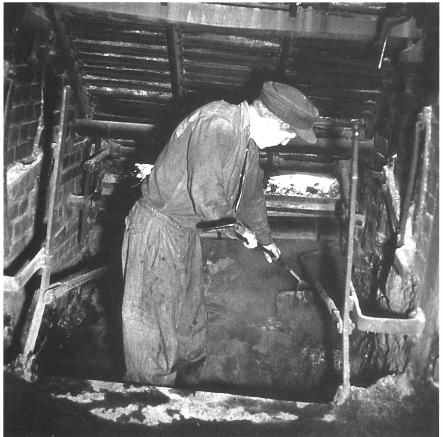
Abb. 12: Heizer beim Ascheziehen an der Treppenrostfeuerung der Saline Hallesche Pfännerschaft, um 1960
