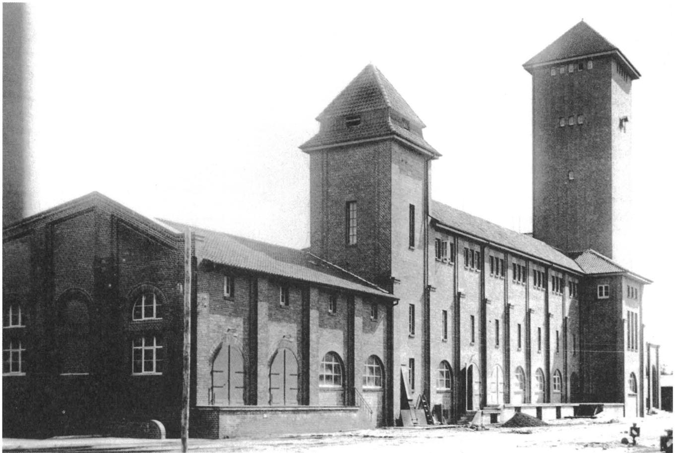
Abb. 3: Die Anlagen der Elektrischen Zentrale (rechts vom Wasserturm) und des Kesselhauses (links) wurden modernisiert und dabei im Inneren stark verkleinert. Dies schuf Platz für weitere Lagerhallen
