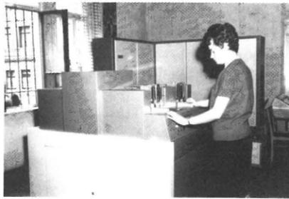
Abb. 13: Lochkarten-Ein- und Ausgabegerät mit der Zentraleinheit des elektronischen Lochkartenrechners „Robotron 100“ im Hintergrund
